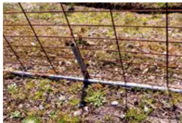
接地面を確実に固定
