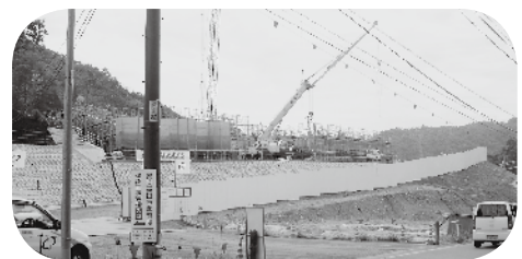
竣工に向け急ピッチ
