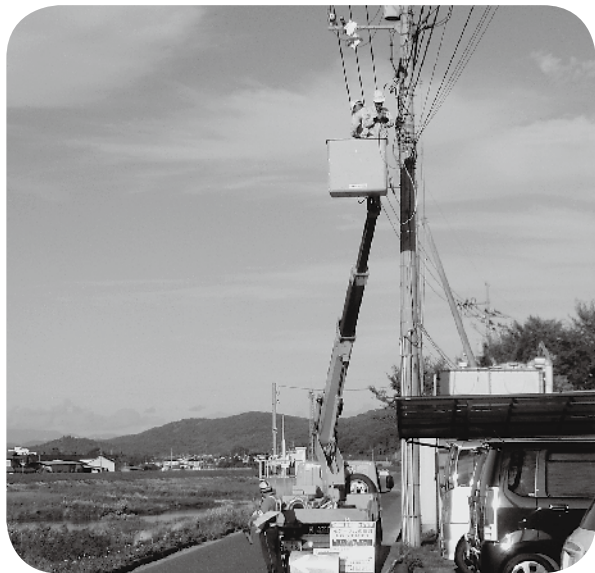
工事が進む光ネット網
