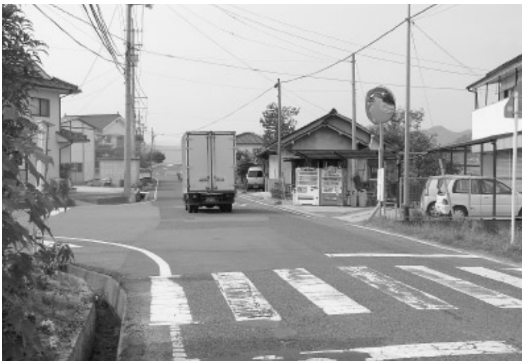
安全で安心な歩道整備を (清風会周辺道路)
