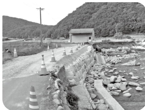
応急工事現場
