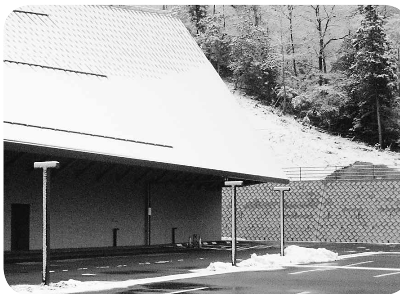
改善が望まれる障害者用駐車場
