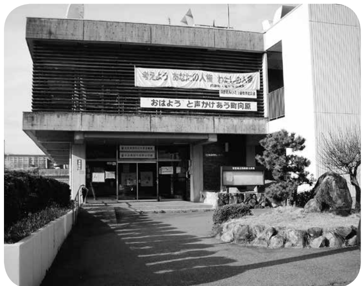
解体予定の旧向原公民館
