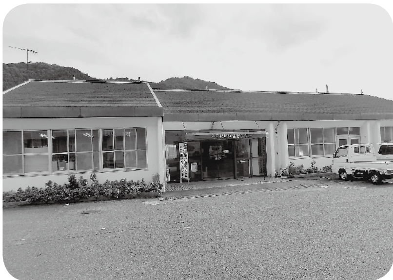
老朽化状況調査対象の八千代保健センター
