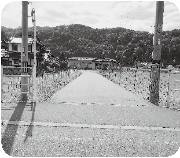
地域農道リフレッシュ事業で 舗装された道
