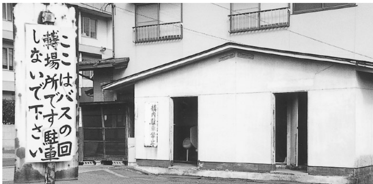
移設改築決定の公衆トイレ（吉田町）
