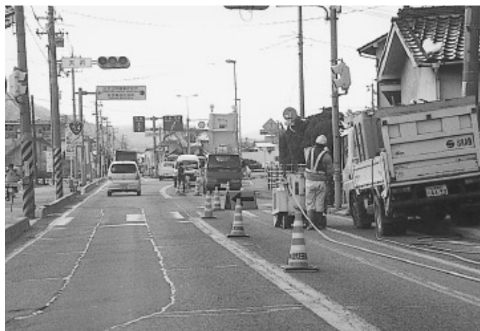
下水道整備が進む吉田地区
