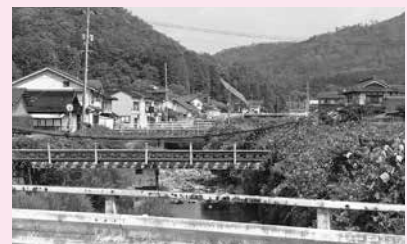
改修が止まったままの大土川（甲田町）
