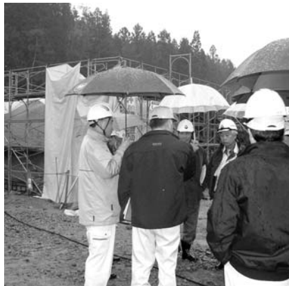
①中山間地域総合整備事業 (甲田町高地長屋地区)
