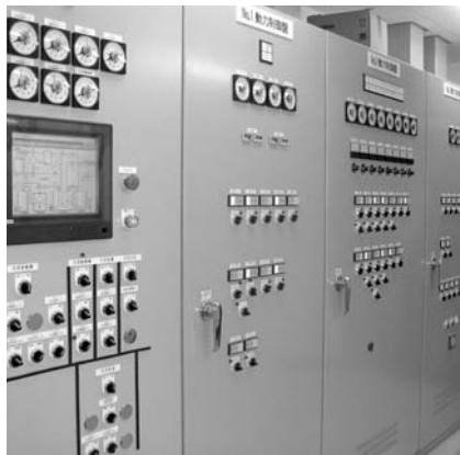
④農業集落排水事業 (向井原地区浄化センター)
