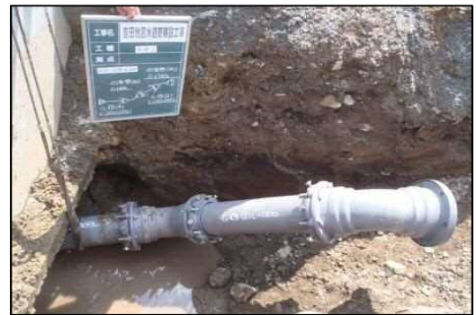
更新管路 (耐震管)
