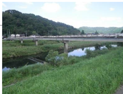
可愛橋 L = 156.3 m (PC橋) 1968年 架設
