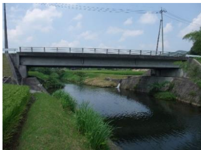
美土里橋 L = 30.0 m (PC橋) 1978年 架設
