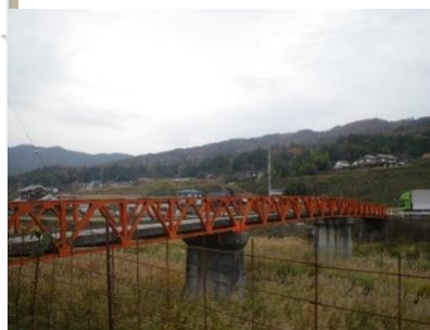
鹿洲橋 L = 51.5 m (鋼橋) 1971年 架設
