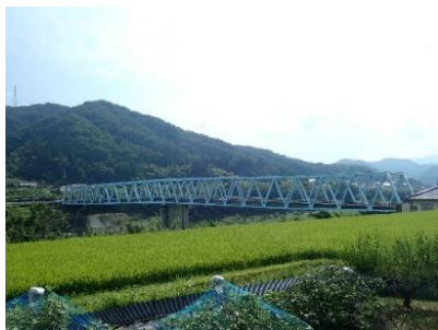
香淀大橋 L = 204.2 m (鋼橋) 1985年 架設
