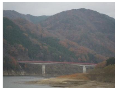
土師大橋 L = 189.1 m (PC橋) 1972年 架設
