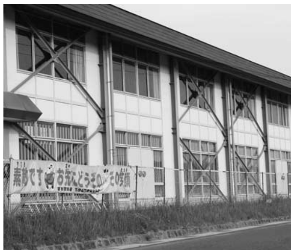
改修済みの来原小学校体育館
