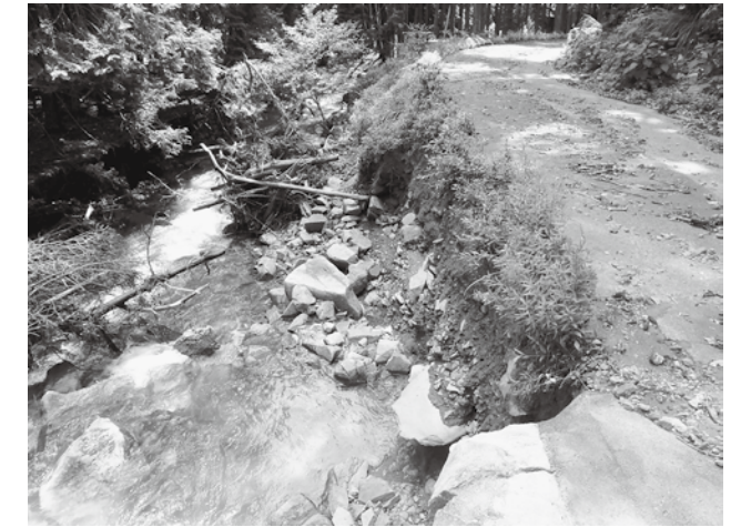
(上) 八千代町の市道潜龍線 (8月20日撮影)。(右) 向原町の林道虫居谷線 (7月20日撮影)。どちらも豪雨により路肩が崩れている。
