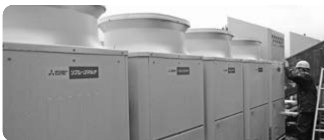
改修される空調設備(向原支所)
