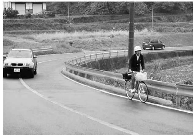
通学路歩道未設置箇所（美土里町北）
