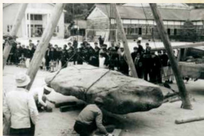
建設中の石碑
