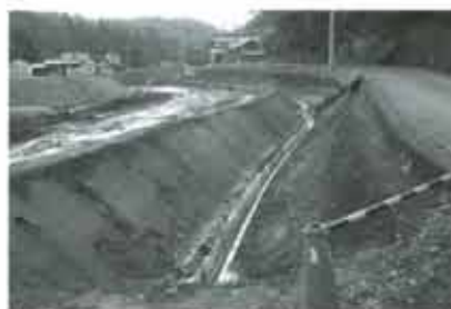
農業用排水施設の施工状況(イメージ)
