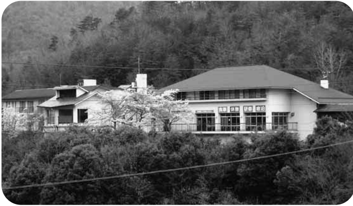
建て替えられる八千代サイクリングターミナル
