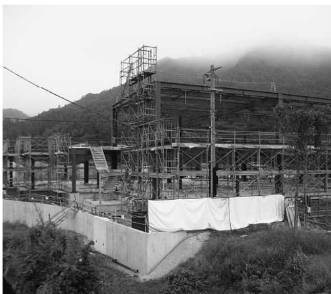
建設中の給食センター
