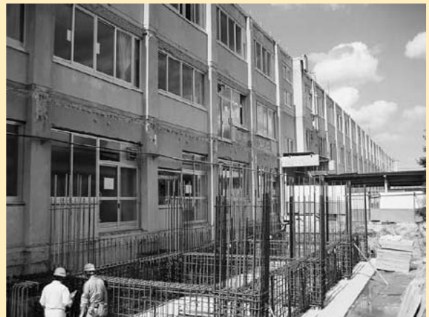
吉田中学校耐震改修（改修中）
