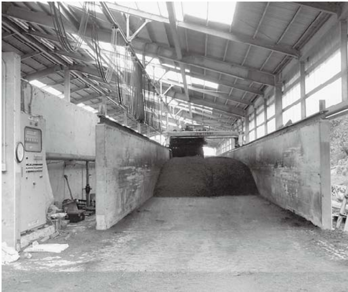
甲田堆肥センター
