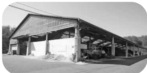
甲田堆肥センター
