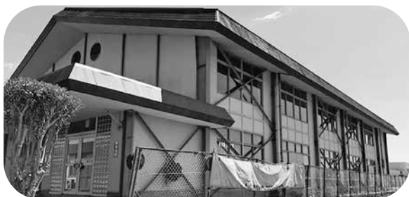
社会体育施設として管理される旧来原小学校体育館
