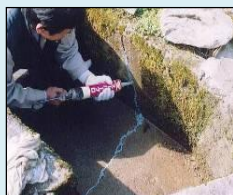
ひび割れの補修
