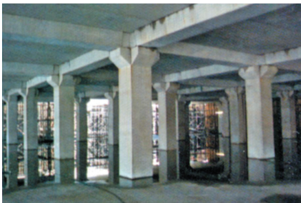
■大州貯留池写真 都市防災施設として計画された大洲貯留池。柱・梁・スラブをプレキャスト化し、短い工期に対応しています。
