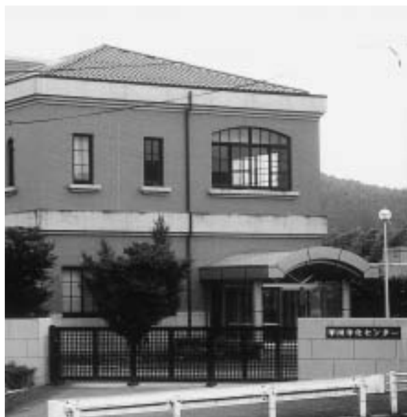
甲田浄化センター工事は20年度で完了
