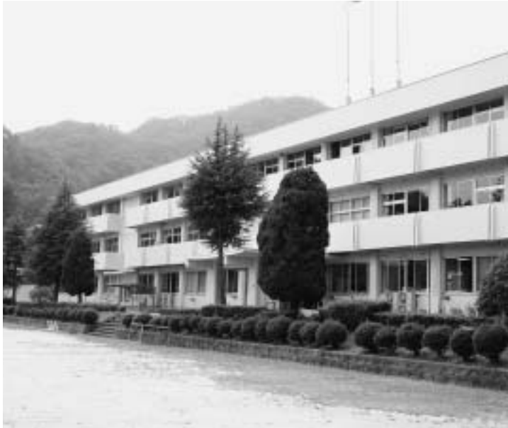
耐震改修されている美土里中学校
