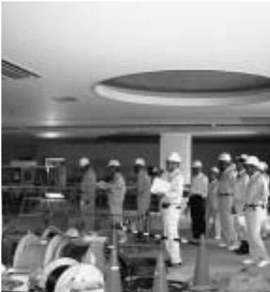
内装工事が進む 新庁舎・文化センターを視察
