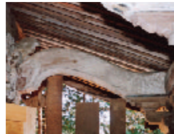
写真3 日高山神社本殿・海老虹梁
