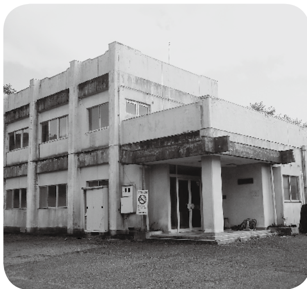
あさかげ 解体される朝光寮
