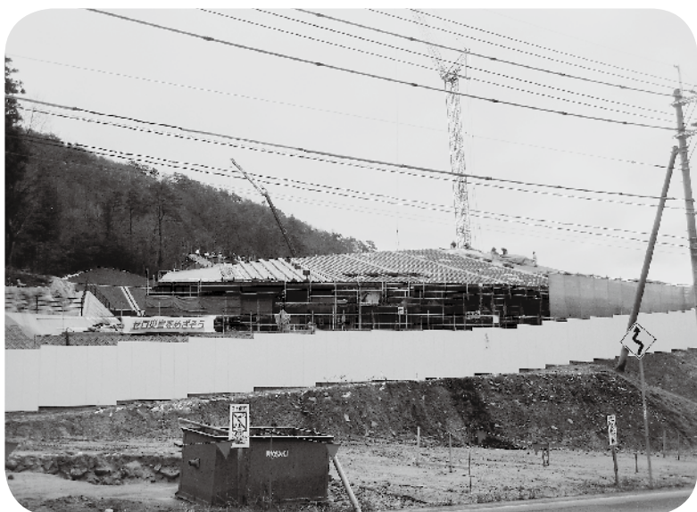
4月1日稼動に向け工事が進む葬斎場
