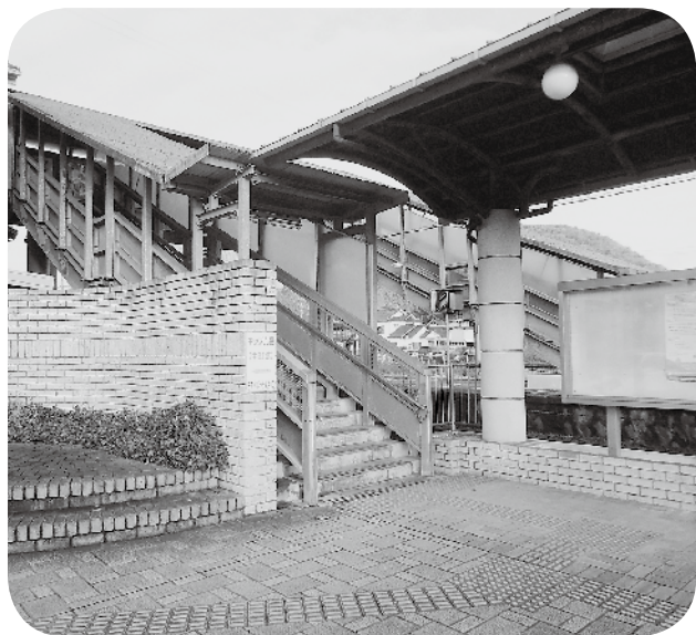
要望の強いエレベーター設置 (甲立駅)
