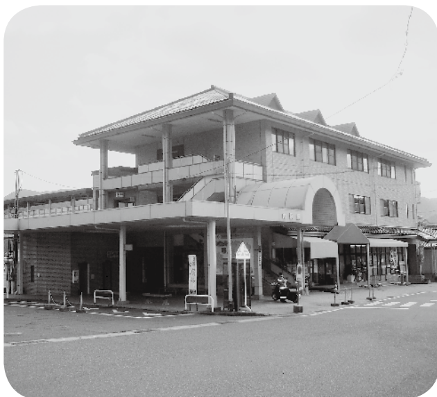
向原駅 プラットハウス
