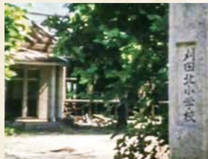
骨組みのみの状態で解体を待つ刈田北小学校。
