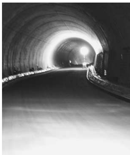
中馬農道のトンネル工場現場
