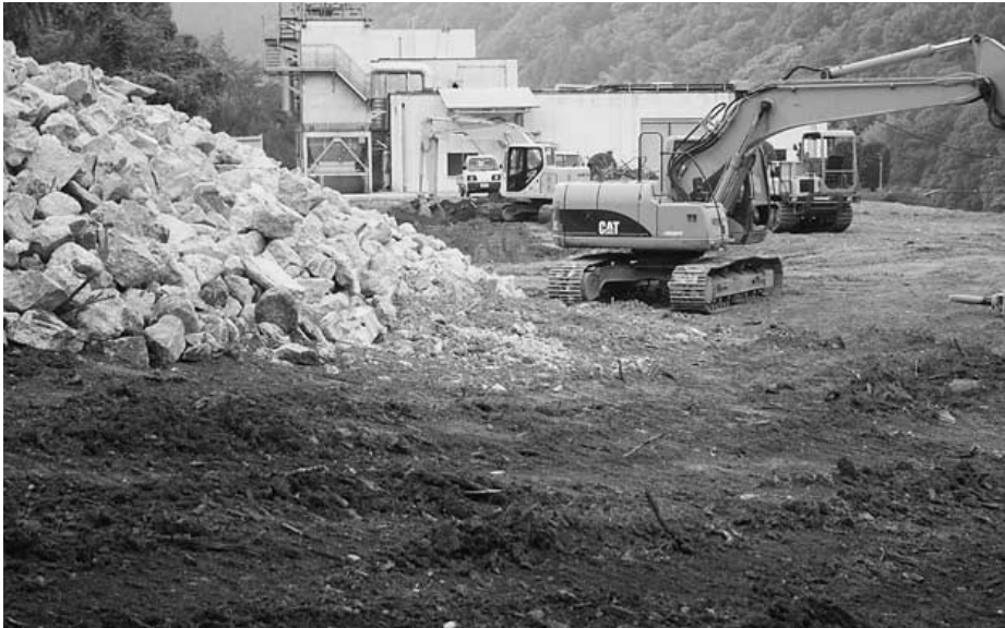
整備の進む清流園改修予定地
