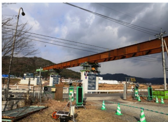
建設中の東広島高田道路
