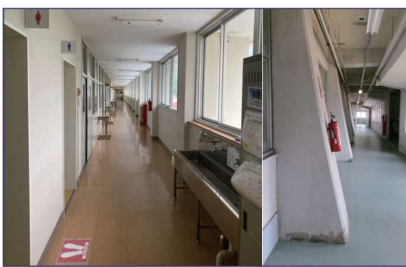
既存校舎：廊下
