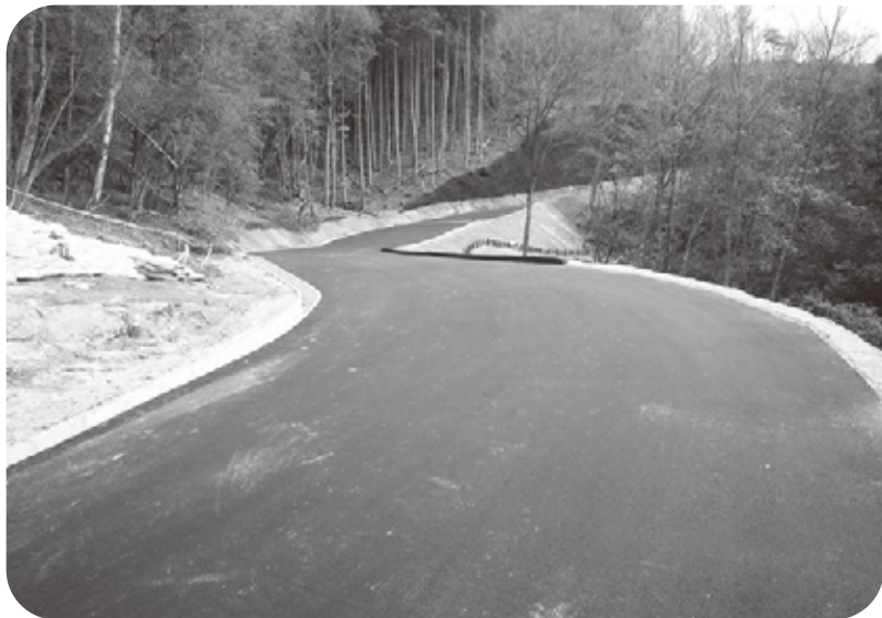
29年度完成見込みの林道入江戸島線
