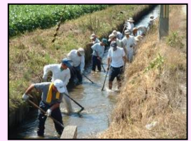
水路の泥上げ
