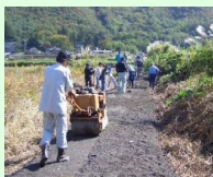
未舗装農道の舗装
