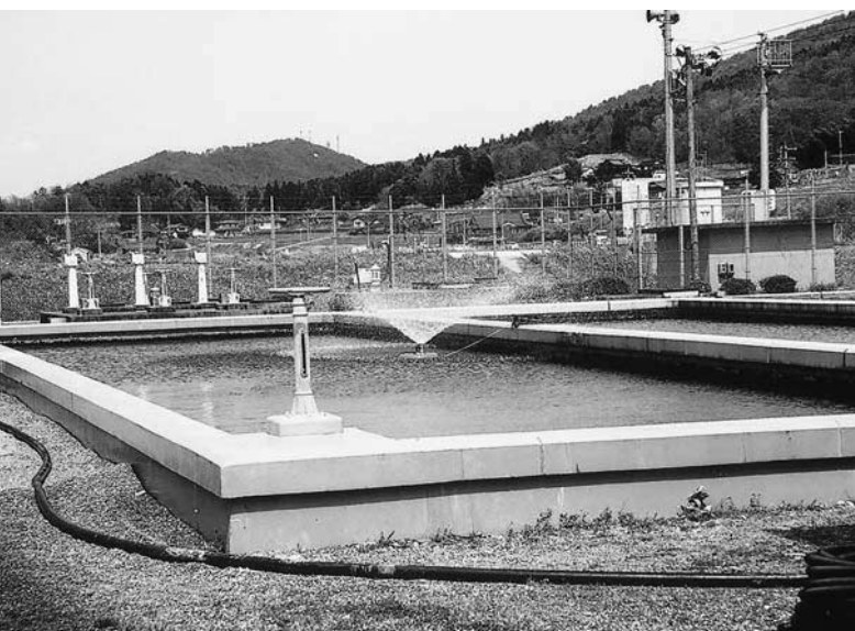
小原浄水場（甲田町）
