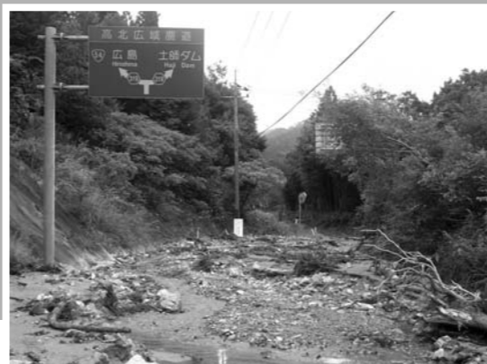
溢れた土砂で交通が寸断 (八千代町土師)
