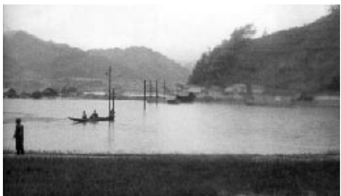
昭和47年の災害で川根は壊滅的な被害を受ける。同じ年、川根振興協議会が設立。災害復興と地域の将来の危機感からの設立だった。
