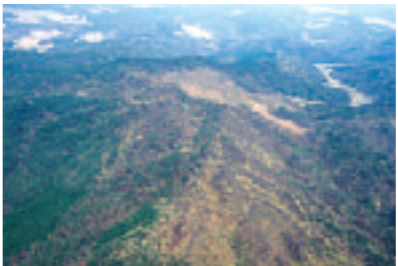
▲風越山陣所跡 (尾根上部分)
